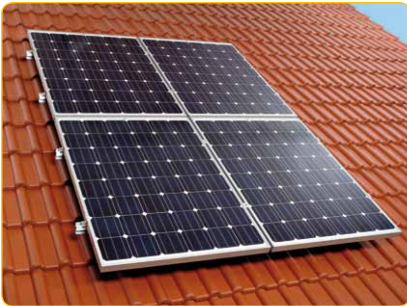
MONIER PV - uitvoering bovenop het dak
