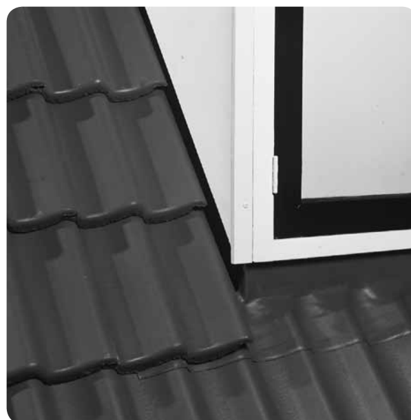
Verholen goot verwerkt langs dakkapel afgewerkt met WAKAFLEX®.
