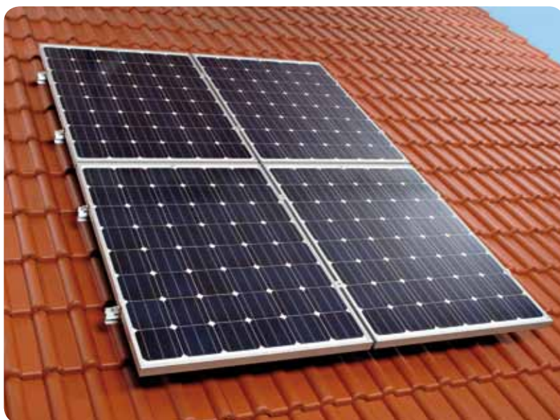
MONIER PV - pose sur la toiture
